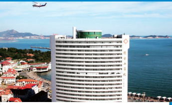
1999年，烟台山医院的24层病房大楼投入使用。
